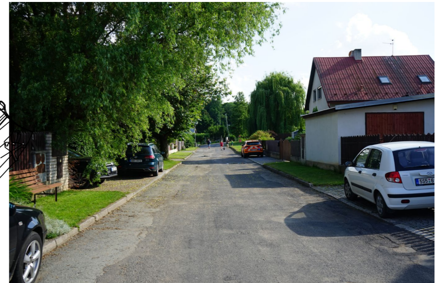
Zahradní ulice se dvěma travnatými pásy a chybějícím chodníkem
