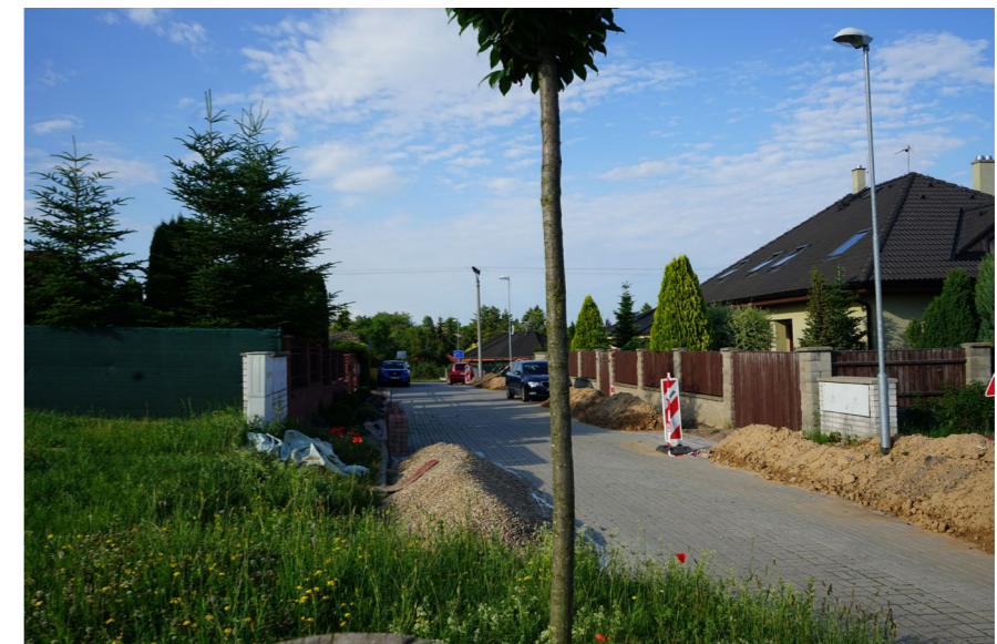
Havrdova zahrada - po jedné straně výkop, po druhé straně osázený vegetační pás
